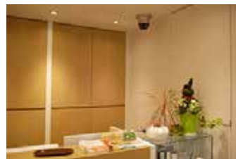
来院を確認するため、入り口にカメラを設置。
