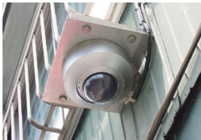
倉庫の壁面に設置されたBB-SW374。 パン・チルト・ズームで広範囲をしっかりと捉える
