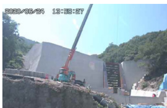
災害関連の砂防工事のリアルタイム映像
