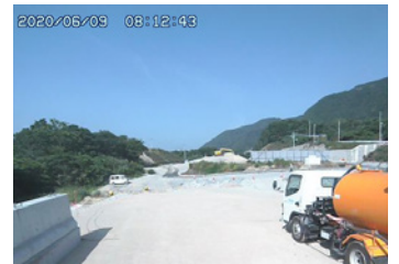
道路改良工事のリアルタイム映像
